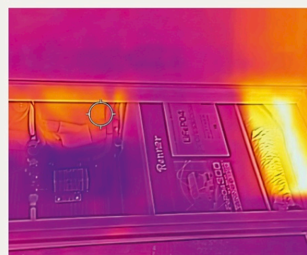
Der nach hinten führende Warmluftkanal liegt neben der Lithium-Batterie. So wird sie im Winter zügig aufgewärmt
